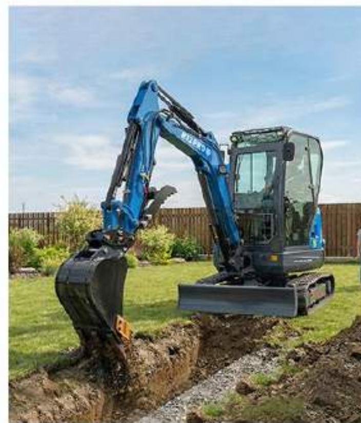
DIG DRAINAGE DITCHES
