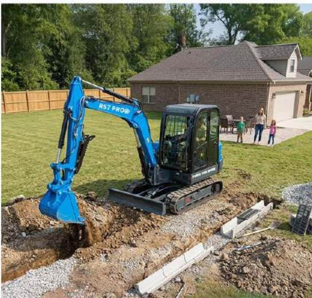
DIG DRAINAGE DITCHES
